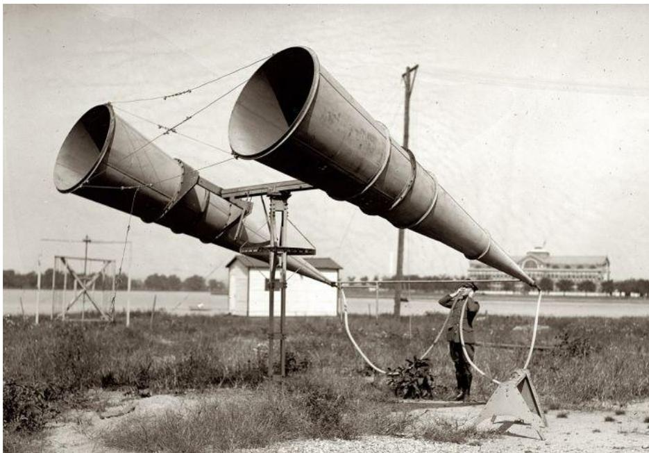
Pendant ce temps là, en Tchécoslovaquie, on mettait au point un double appareil utilisant des pavillons monstrueux renvoyant le son, à la façon d'une antenne satellite, vers d'énormes tubes reliés aux oreilles de deux opérateurs. Il est facile de deviner que leur manipulation ne devait pas être aisée, et leur développement fut vite arrêté.
