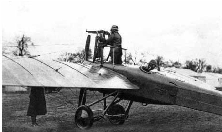
Un Déperdussin de la D 4 en sept 1912. Remarquez la position du mitrailleur lui permettant de tirer au-dessus de l'hélice. Athlétique comme posture !
