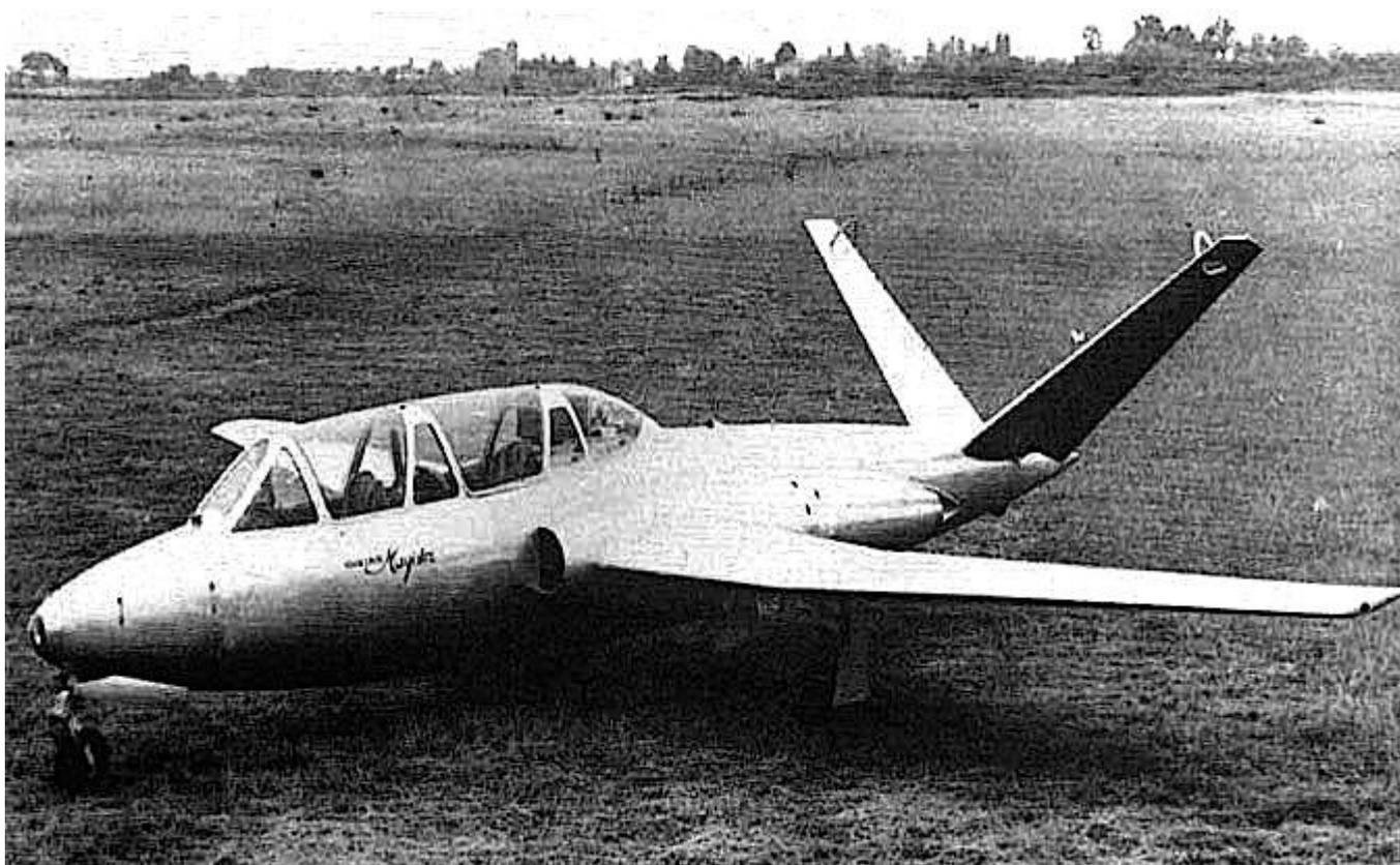
*Cette photo du prototype 001 montre un nez plus trapu, un léger dièdre sur la partie externe de l'aile, et l'absence des célèbres bidons en bout d'aile.*
