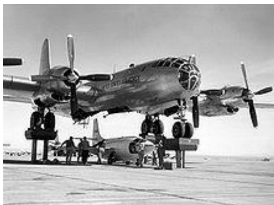
Le X-1/3 en cours de montage sous un RB-50. Identique au X-1/2, le 3 explosa au sol avec son porteur avant son troisième vol
